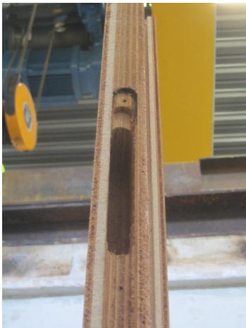
Foto 1 ; Sluitzijde deurblad ter plaatse van sparing slot
