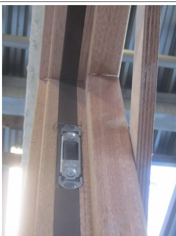
Foto 3 ; Kozijn aan de sluitzijde.
